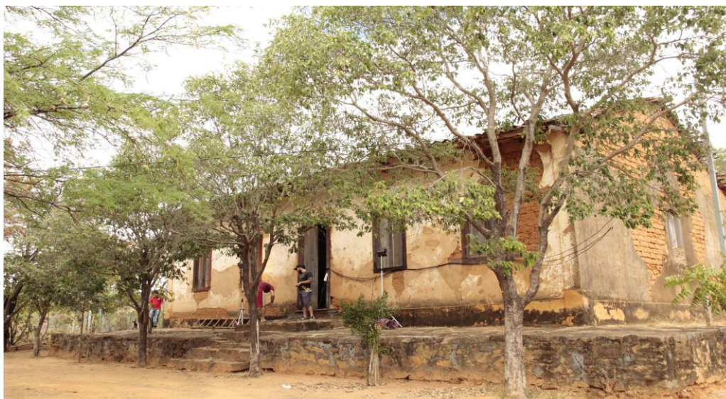
Figura 5 - fachada da locação (casa de Amélia)
