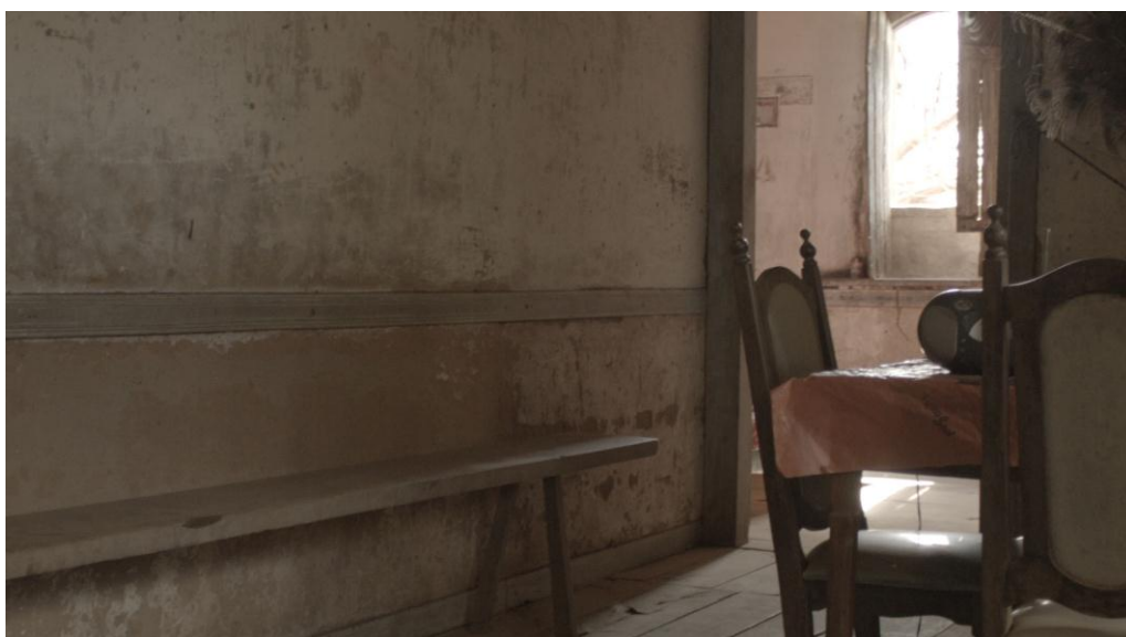
Figura 8 - Sala de Amélia (antes do tratamento de arte)
