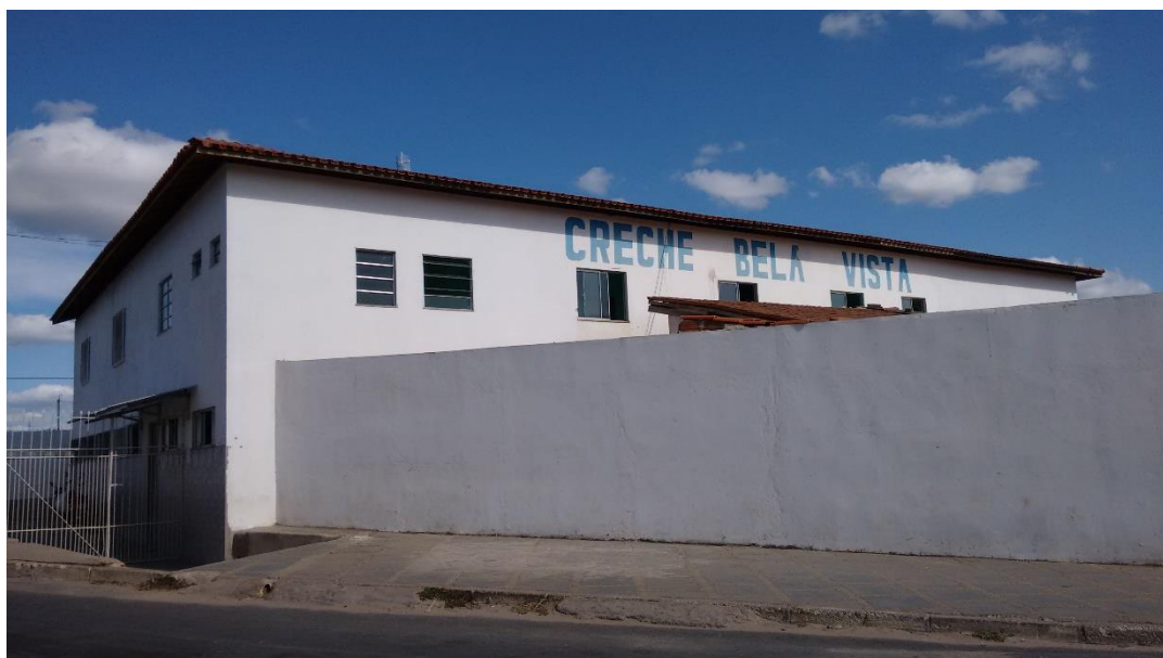
Figura 1 – Fachada do prédio da Creche Bela Vista
