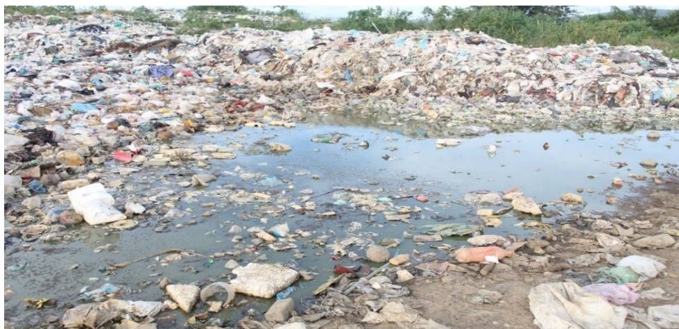
Figura 4: Presença de chorume no solo do lixão de Poções-BA
