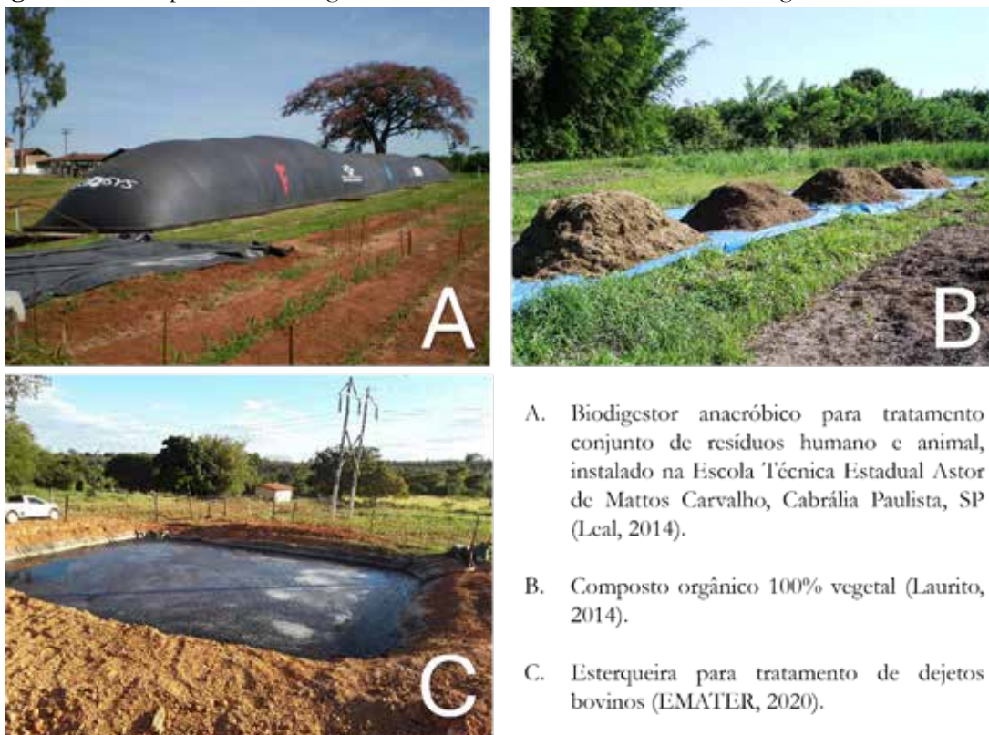
Figura 1 – Exemplos de tecnologias utilizadas no tratamento de resíduos orgânicos no meio rural
