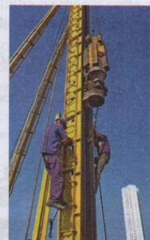
O martelo que cai faz a estaca penetrar no chão.
