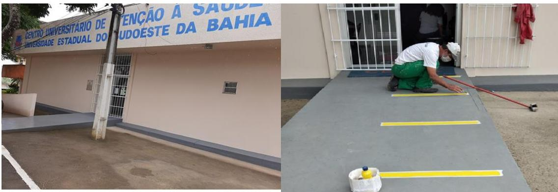
**Figura01. Pintura externa, demarcação piso e criação estrutura para instalação lavatório.**
