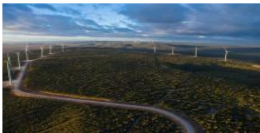
Imagem aérea do Complexo eólico Morrinhos.
