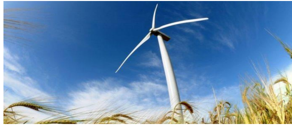
Imagem de um aerogerador, Fonte: Portal Energia
