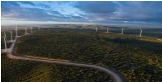
Imagem aérea do Complexo eólico Morrinhos.
