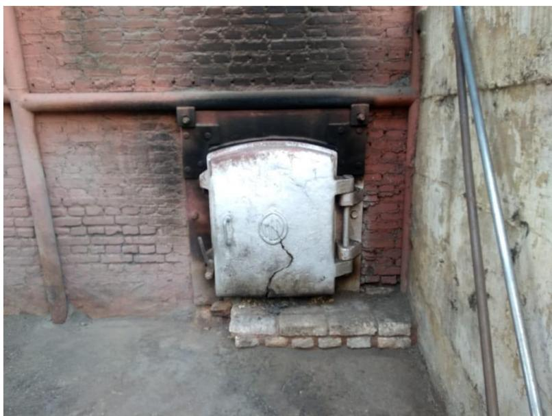
Figura 5 - Fornalha onde se realiza a queima de parte do bagaço produzido a partir da moagem da cana. Fonte: Acervo pessoal.
