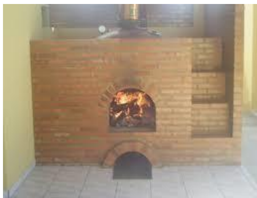
Figura 1 - Fornalhas com paredes refratárias para evitar os efeitos da dilatação térmica
