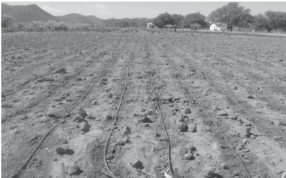
Figuras 29. Instalação do sistema de irrigação na área experimental.
