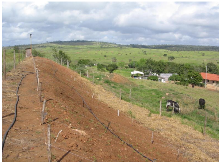
Figura 3 - Talude onde foi implantado o experimento.
