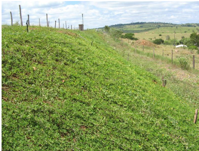
Figura 8 A – Talude no final do experimento.
