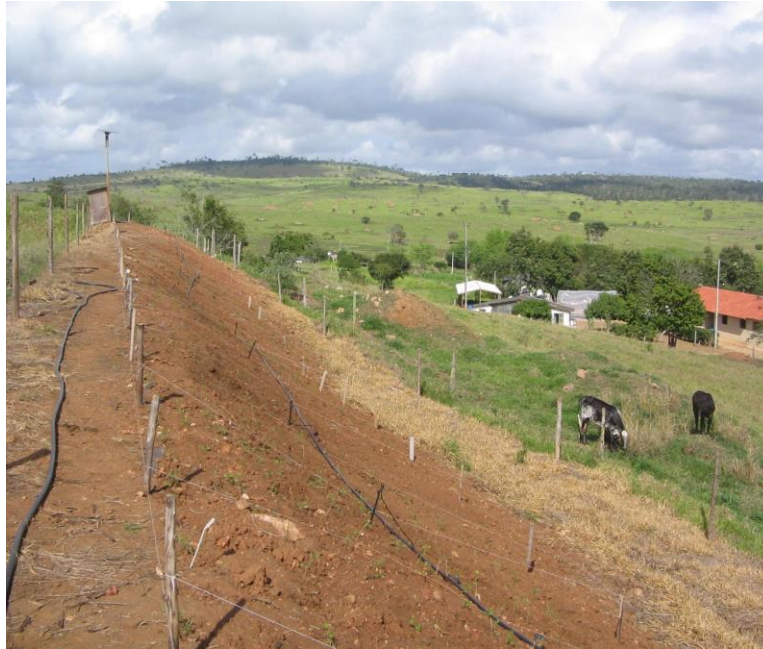
Figura 7 A - Talude no início do experimento.
