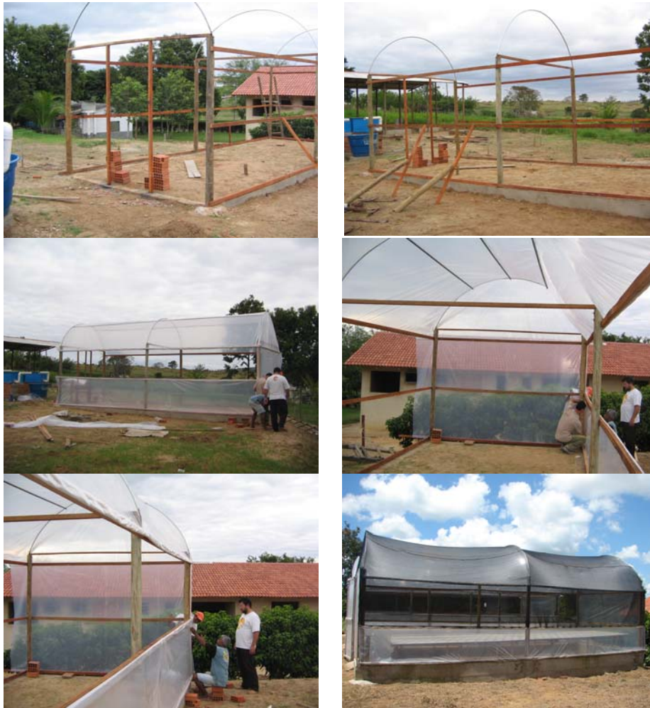
Figura 2 A – Construção das estufas de produção hidropônica Itapetinga – BA. UESB, 2007.
