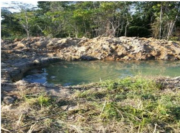
Figura 25 – Aberturamecânica de tanque.
