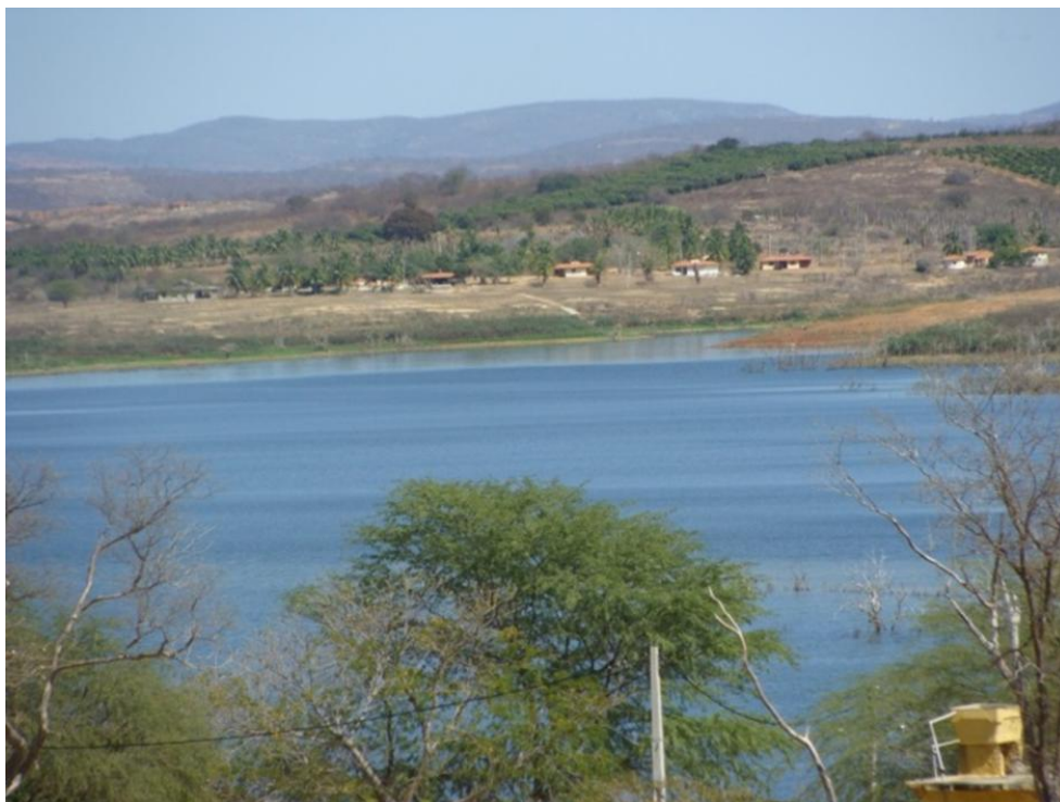
Figura 3. Barragem do rio Gavião, em Anagé, BA, 2013 (Fonte: Autor).
