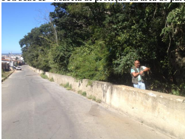
FIGURA 13 - Mureta de proteção da área do parque localizada no bairro Guarani
