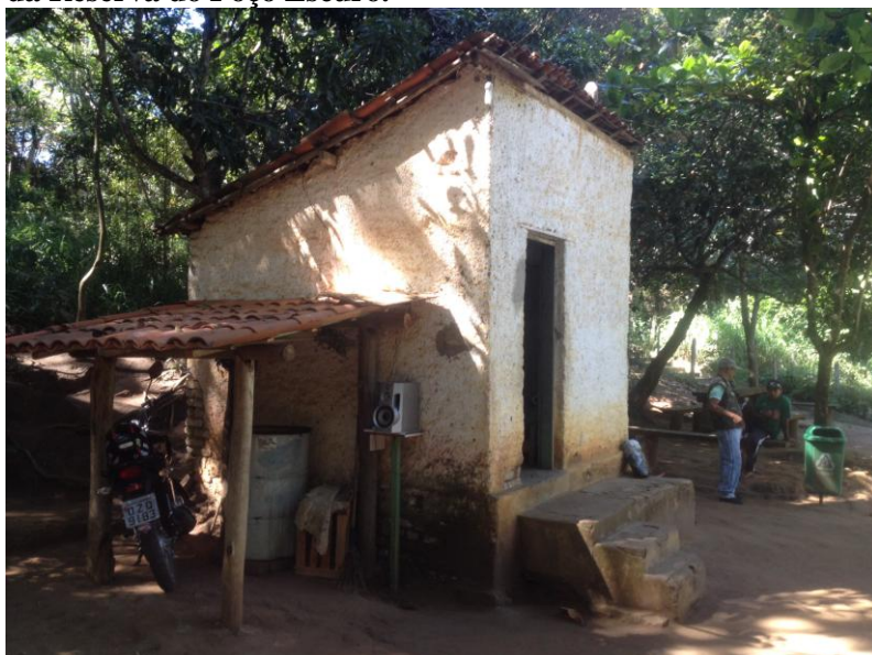
FIGURA 5 - Área de armazenamento de equipamentos e único “escritório” dos funcionários da Reserva do Poço Escuro.
