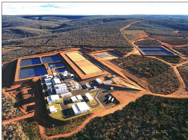
Figura 27: Vista aérea da unidade de mineração e beneficiamento de urânio URA-Caetité [1].)
