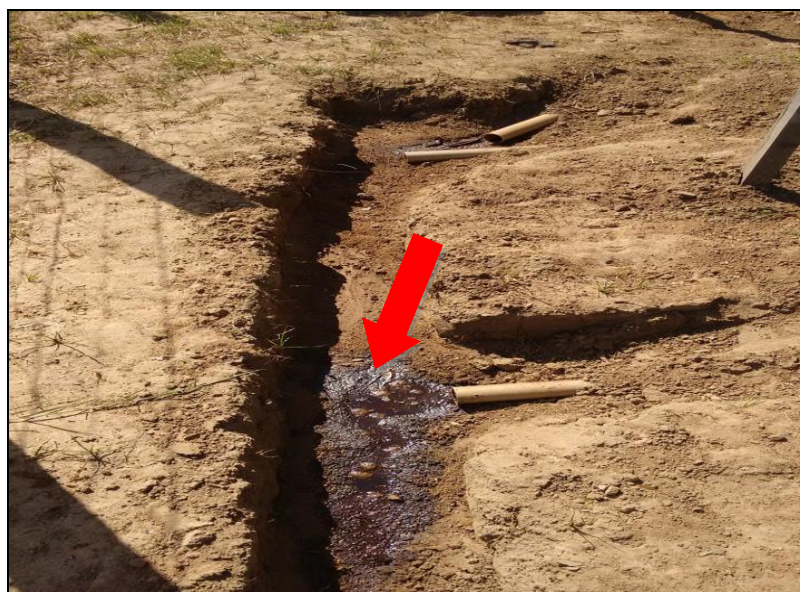
Figura 9. Drenagem do chorume oriundo dos resíduos experimentais compostados
