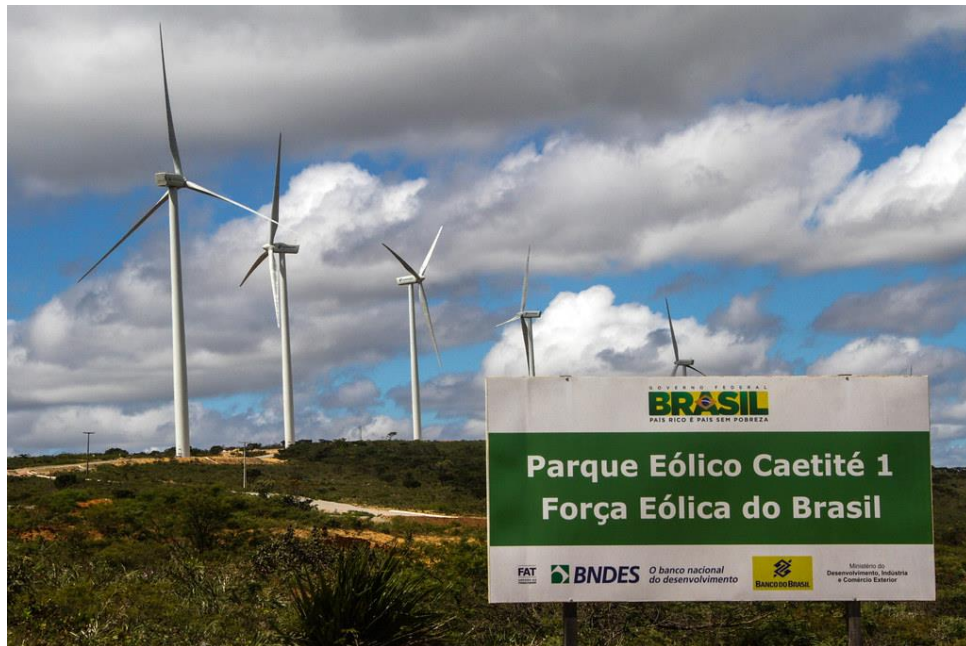
Figura 10 – Aerogeradores do parque eólico em Caetité- Bahia.
