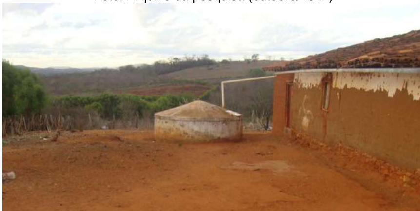
6. Cisterna de placa
