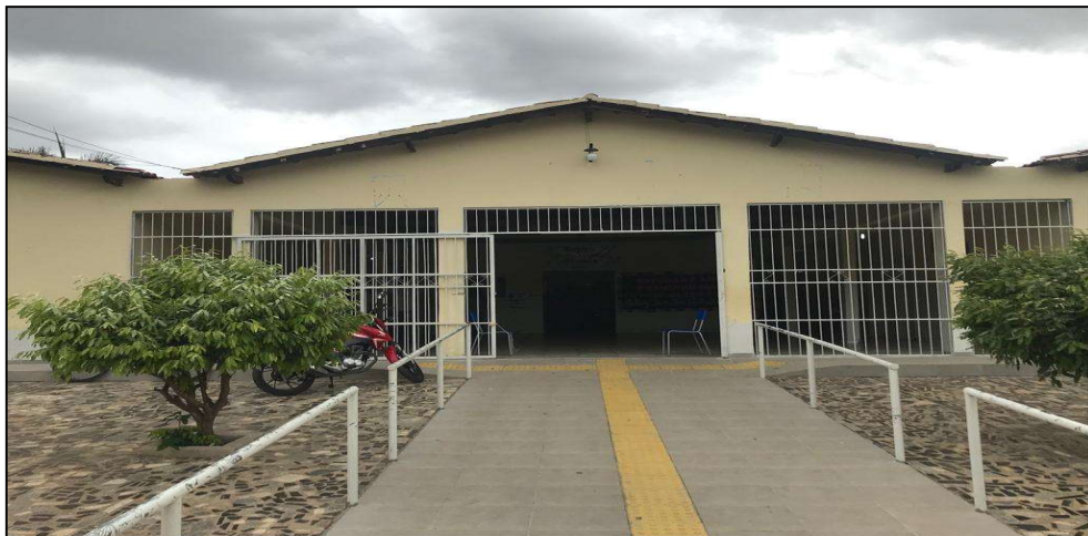
Figura 2: Fachada da Escola Municipal Juvenal Wanderley
