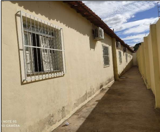
Figura 5: Grades em evidência vista pela lateral da escola
