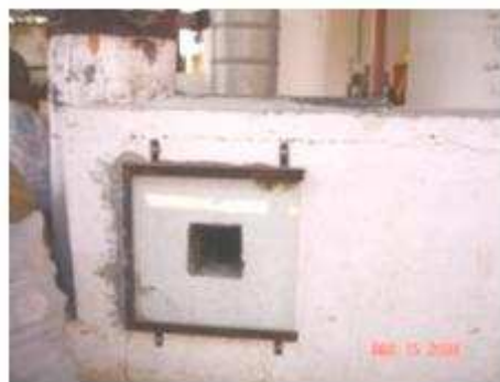
Figura 19 – Janela para visualização da chama piloto (Ch 3).
