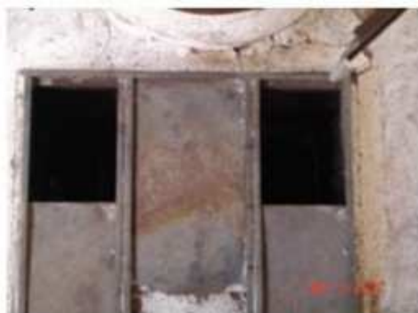
Figura 23 – Abertura A2: entrada de ar primário com as regiões laterais abertas.
