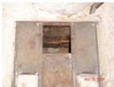
Figura 22 – Abertura A1: entrada de ar primário com a região central aberta.
