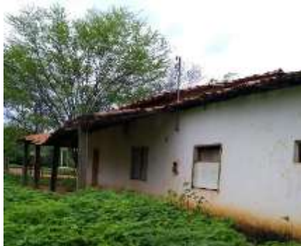
Figura 16: Lateral direita da primeira escola do Novo Zabelê (casa da fazenda)
