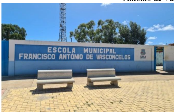
Fachada externa da escola
