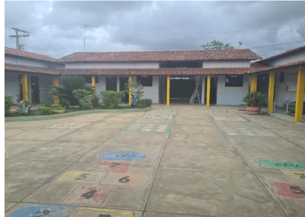
Parte interna do portão de entrada
