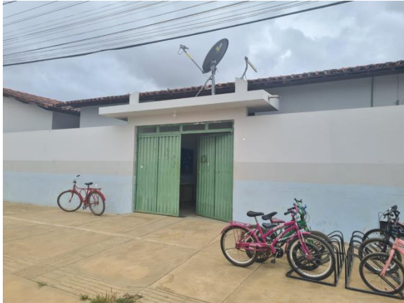
Fachada externa da escola
