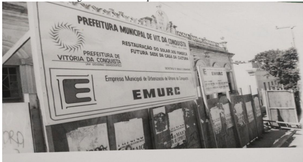
Figura 8 — Restauração do Solar dos Fonseca
