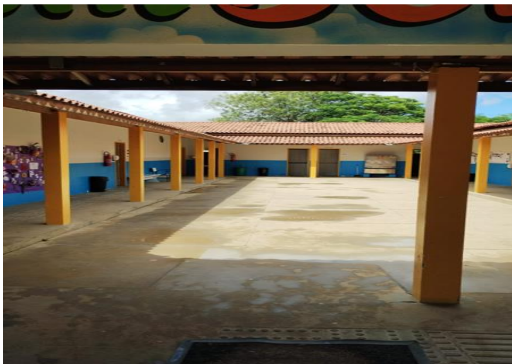
Figura 10 - Área interna da ERPMG onde funcionam as turmas de anos finais do Ensino Fundamental e é servida a merenda escolar (2023)
