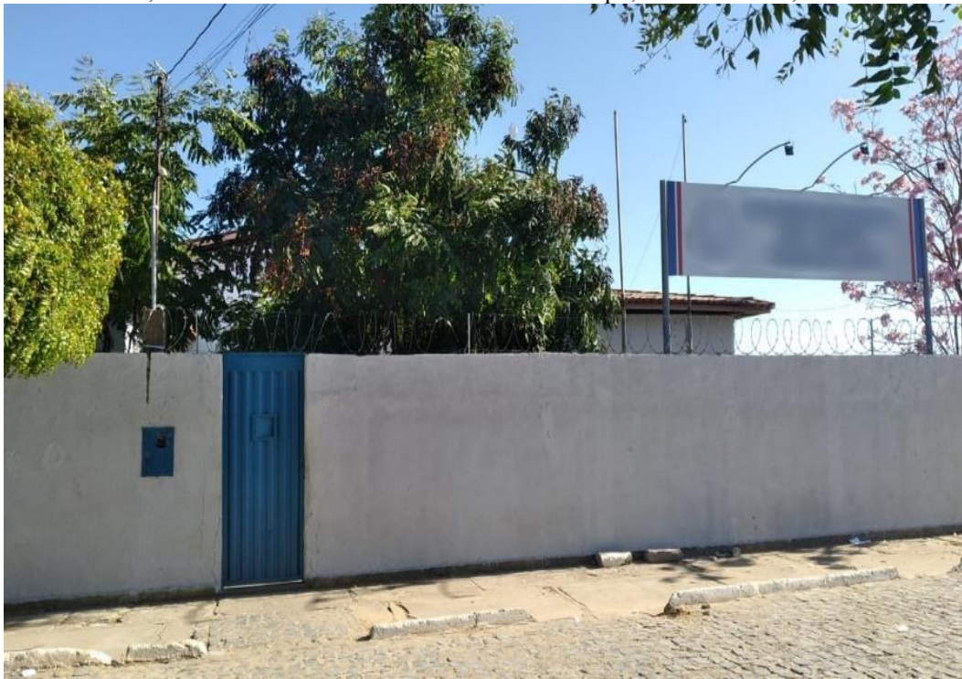
Figura 8 – Fotografia do Colégio Estadual do Campo Miguel Arcanjo - CECMA, localizado no distrito de Gameleira da Lapa, Sítio do Mato, BA.
