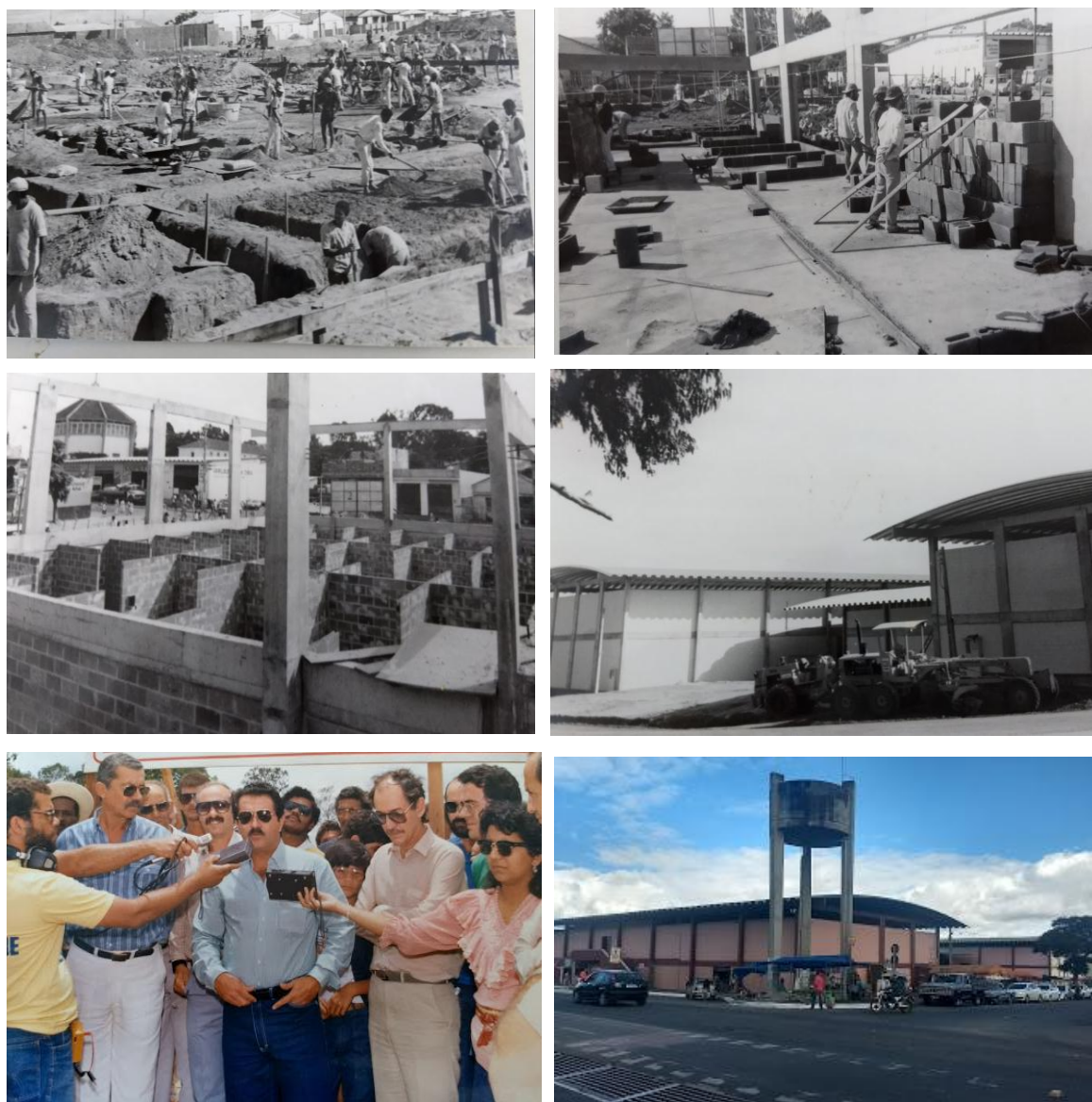
Figura 33 – Construção, inauguração e atualidade do Mercado Municipal do Bairro Brasil.
