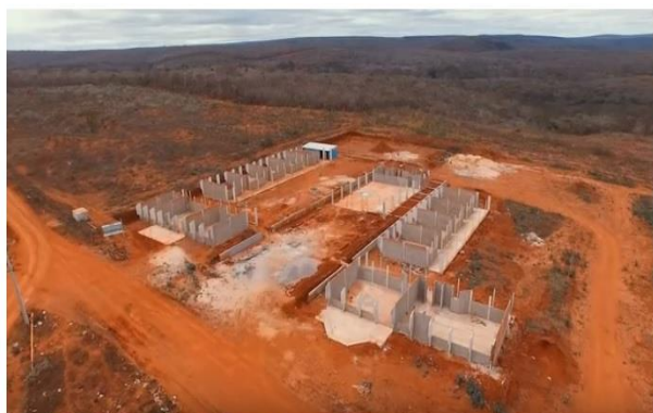
Construção do Centro Administrativo de Caetité (CAC) - 2016
