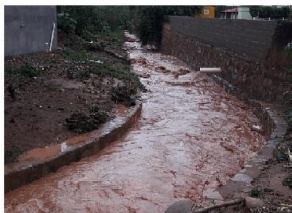
Riacho Pedreiras 2017, pós canalização
