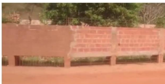
Rio São João (construção no leito do rio) - Bairro Prisco Viana
