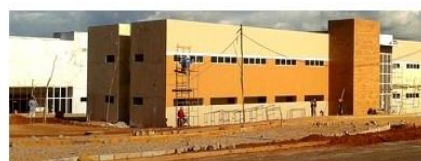
Centro Administrativo de Caetité - Bairro Prisco Viana - 2016
