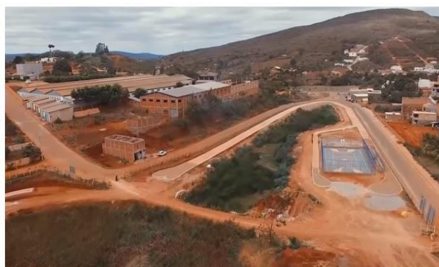
Galpões da Fábrica Fortiori (à esquerda) - Construção do Parque Ecológico (à direita) - 2018
