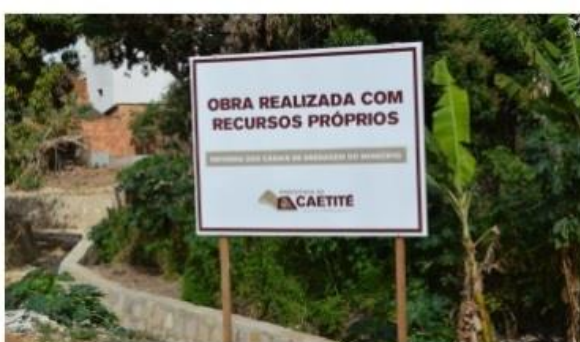
Obras de canalização de drenagens
