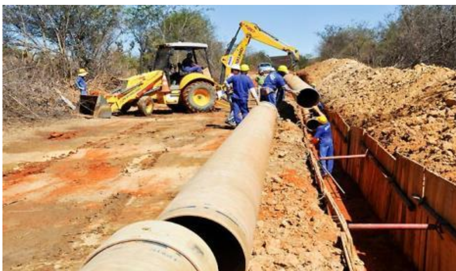
Figura 55 - Implantação da Adutora do Algodão entre Guanambi e Caetité.
