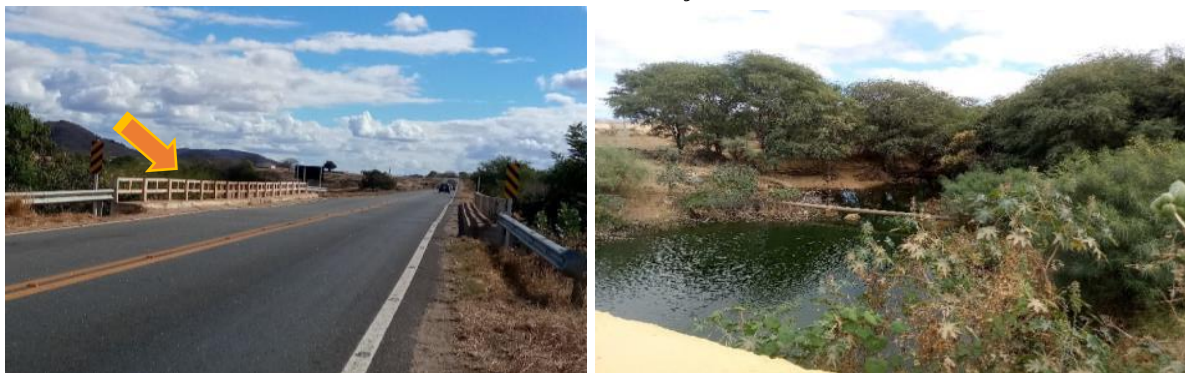
Figura 43 - Fábrica de óleo e farinha de osso sob a ponte do Rio Carnaíba de Dentro, BR 030. A- Fábrica de óleo e farinha de osso. B- Local onde é lançado os resíduos da fábrica.
