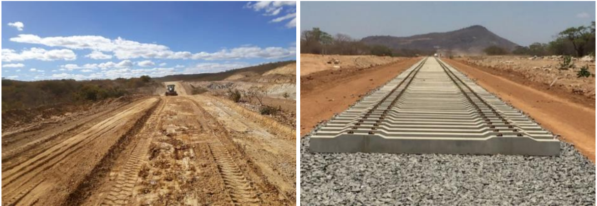
Figura 32 - Ferrovia de Integração Oeste-Leste em construção (Lote 5).
