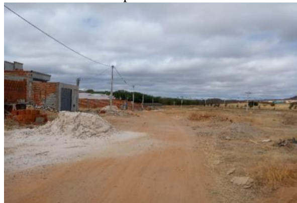
D- Loteamento em planície aterrada
