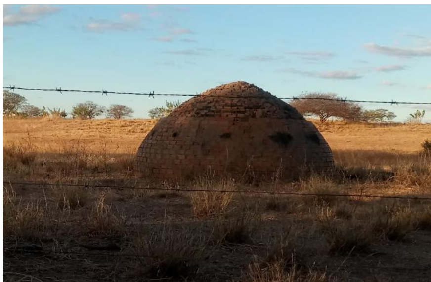
Figura 28 - Forno para fazer carvão vegetal no município de palmas de Monte Alto.
