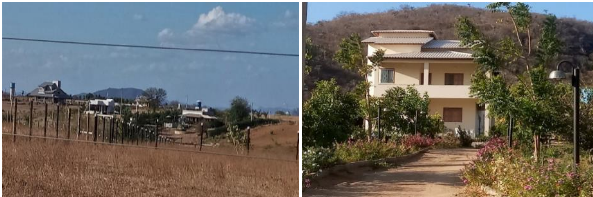
Figura 54 - Casas em volta da barragem Poço do Magro.
