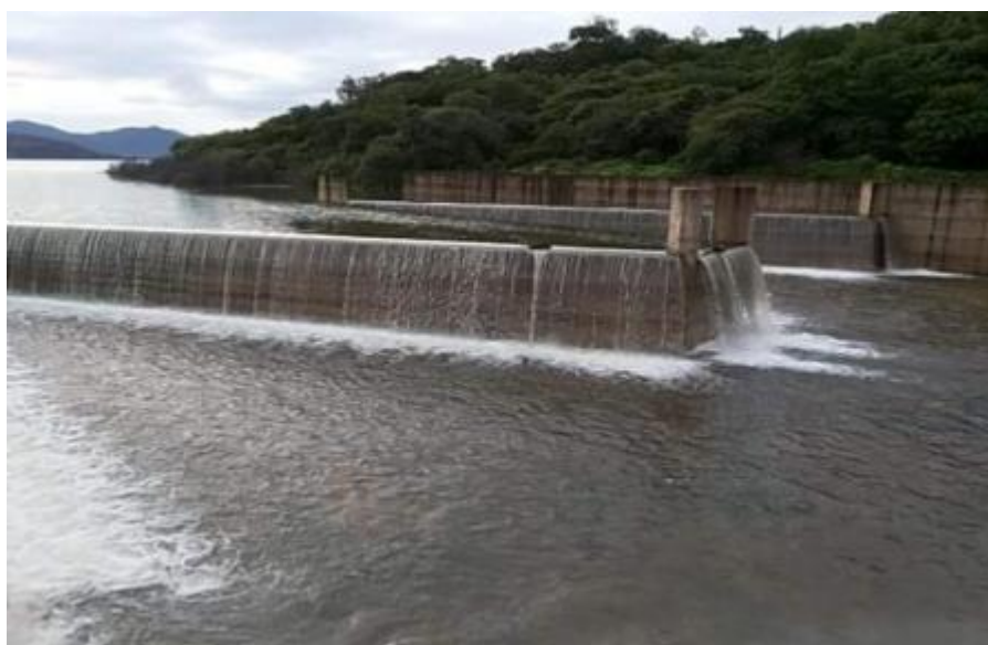
Figura 53 - Barragem Poço do Magro no limite máximo.
