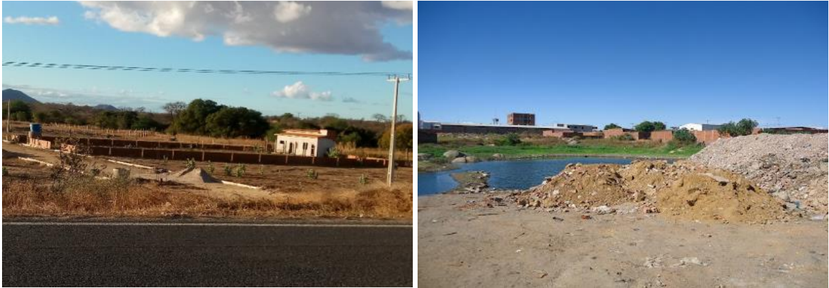
Figura 34 - Ocupação no leito do rio Carnaíba de Dentro no perímetro urbano (BR030) e aterramento de lagoa localizada na BR-030.
