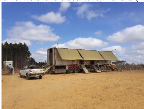
Fotografia 13: Refeitório e escritório, Planalto (BA), 2018.
