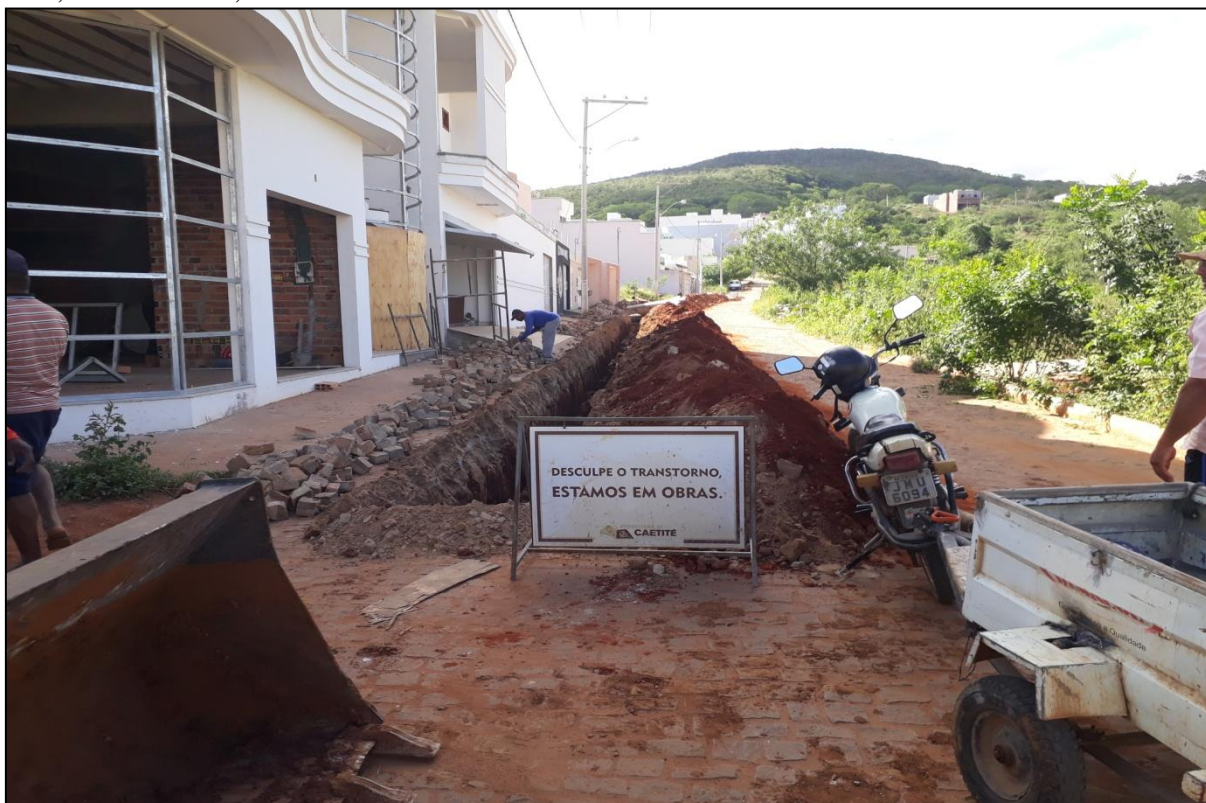
Fotografia 08 - Rede de esgotamento - Rua Capitão João Fraga, Loteamento Village Santa Rita, Caetité - BA, 2019
