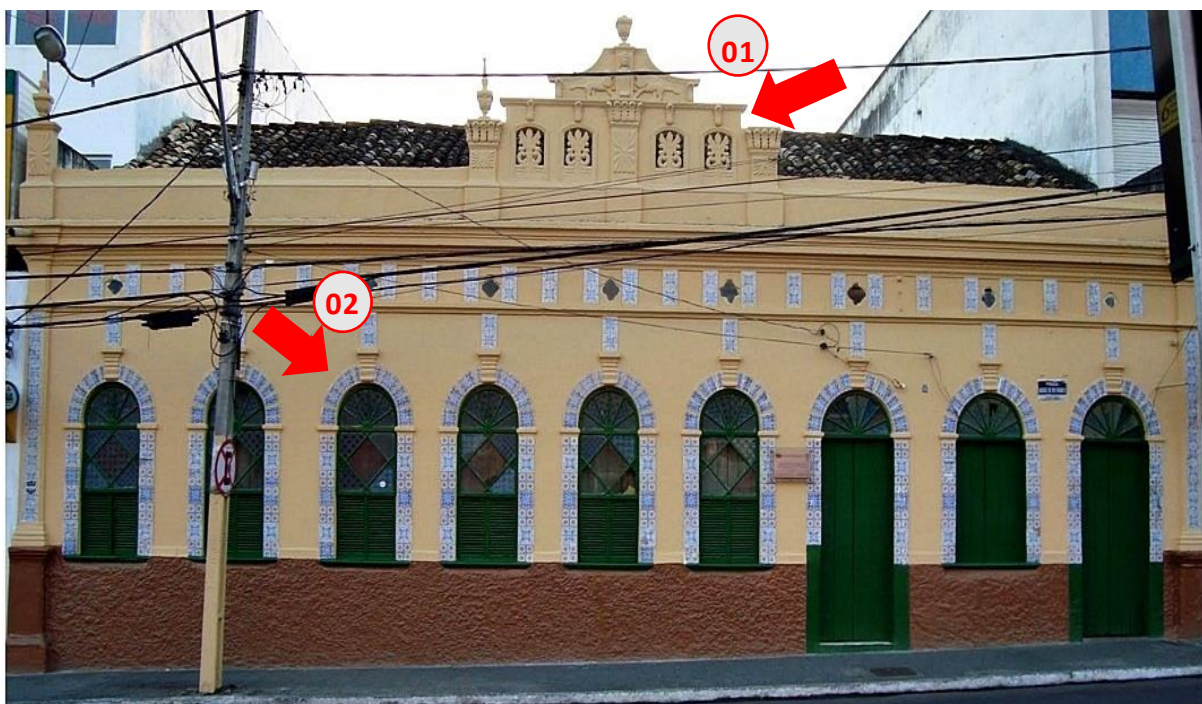
Figura 13 - Fachada Casa de Dona Zaza, 2016.
