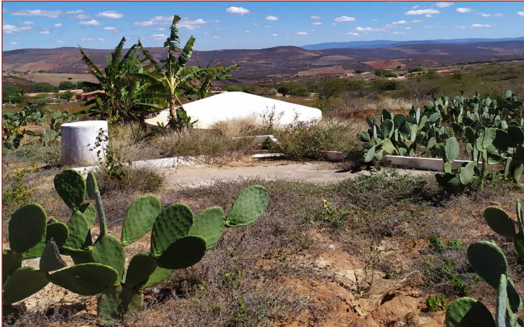
Figura 2 - Cisterna de enxurrada na Faz. Adobo, Aracatu-BA/Brasil (2019)
