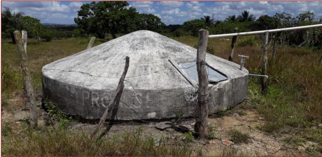
Figura 04 - Cisterna obtida via PRONESE.
