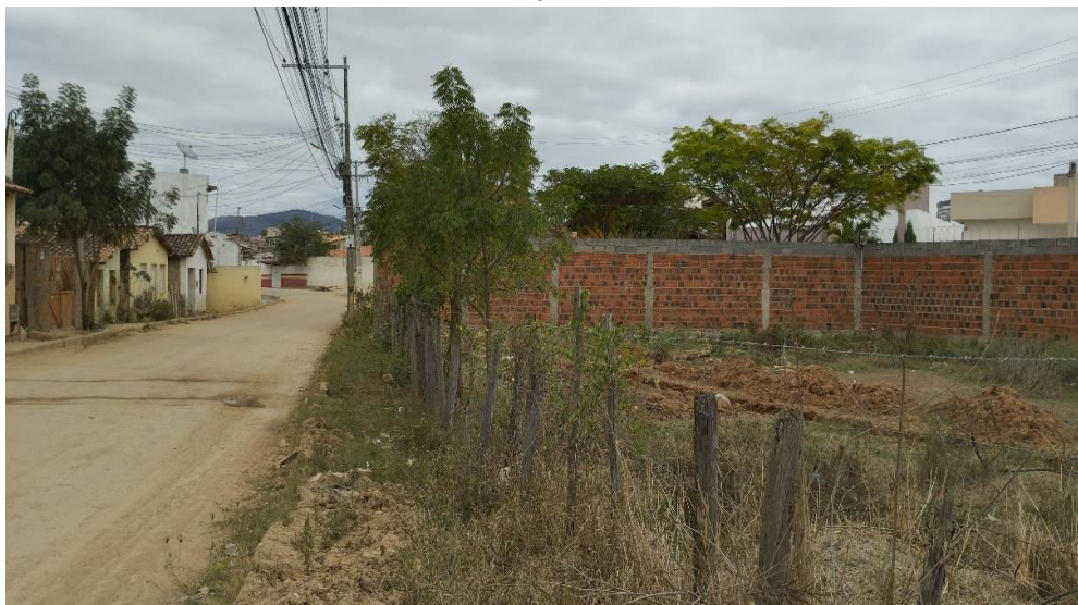
Figura 2 - Limite entre as faixas 01 e 03 Rua Adolfo Rlbeiro, bairro São Judas Tadeu, Jequié/BA, 2022
