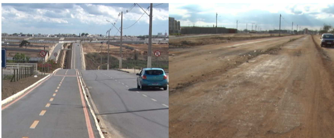
Painel 8 - Corredor Perimetral - primeiro trecho (eixo leste) executada x terceiro trecho (oeste) não executada em Vitória da Conquista – Bahia, 2019
