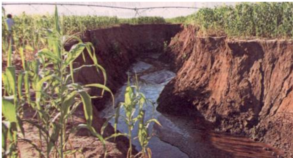
Figura 6 – Erosão com afloramento do lençol freático
