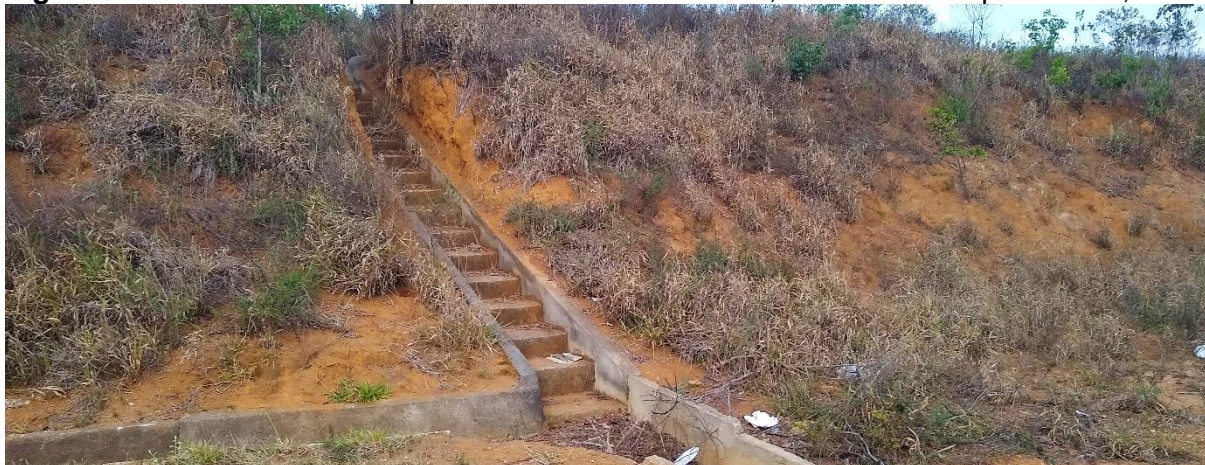
Figura 36 – Escada hidráulica próxima ao Anel Rodoviário, Vitória da Conquista – BA, 2019
