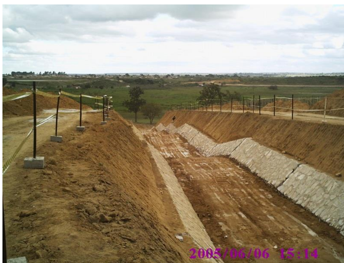
Figura 2: Construção do Parque Ambiental Lagoa das Bateias
