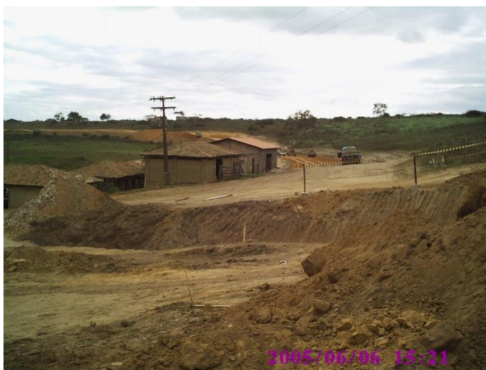
Figura 3: Construção do Parque Ambiental Lagoa das Bateias
