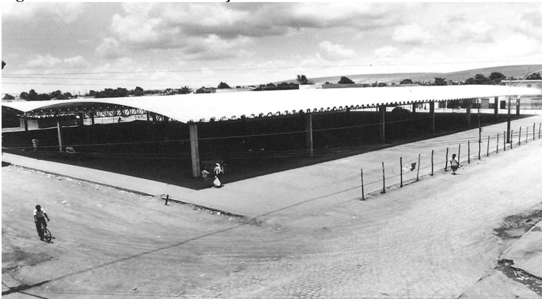
Figura 2 - Pavilhões em construção
