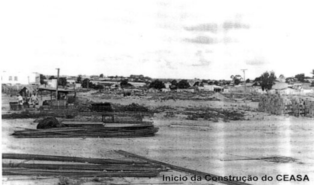
Figura 1 - Canteiro de obras da CEASA
