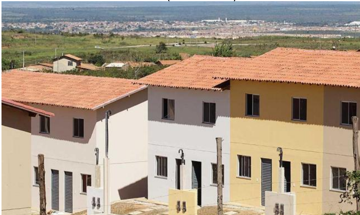
Foto 24. Aspecto das casas de um dos conjuntos habitacionais MCMV/PMHP (Bairro Primavera)
