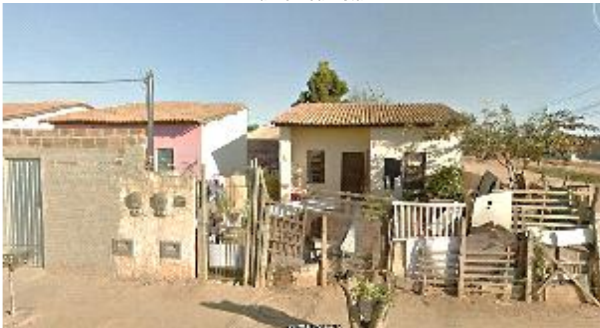
Foto 21. Aspecto de imóveis com perfil popular no Loteamento Vila América – Bairro Boa vista
