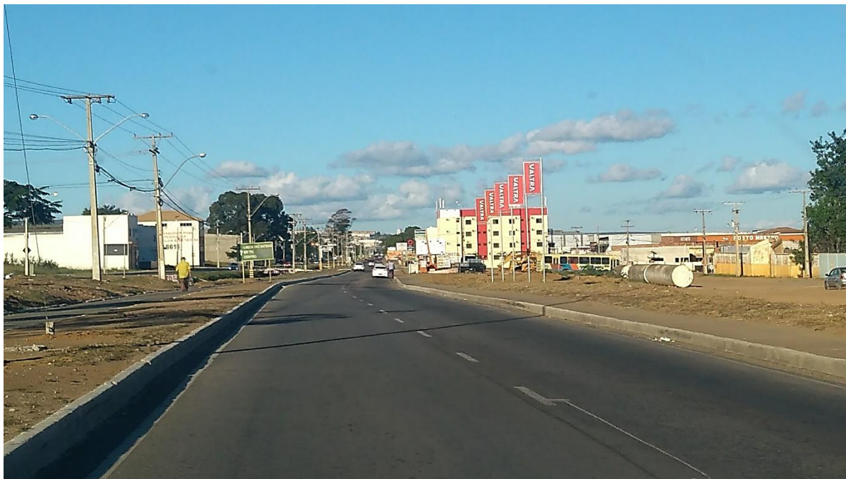
Foto 16. Prolongamento da Avenida Brumado no trecho entre os Bairros Bateias e Zabelê
