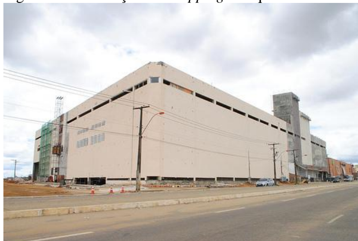
Imagem 18: Construção do Shopping Conquista Sul em 2006
