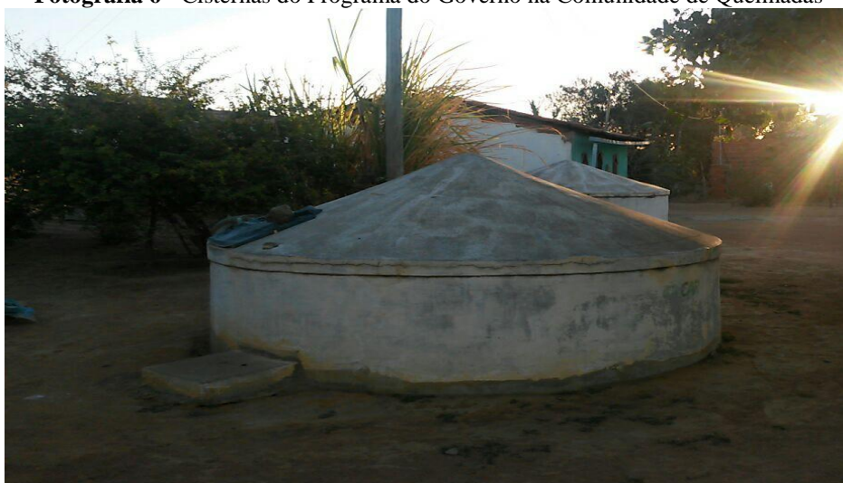
Fotografia 6 - Cisternas do Programa do Governo na Comunidade de Queimadas
