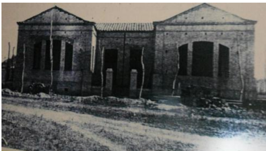
Figura 2 - Fase inicial da construção do Grupo Escolar Getúlio Vargas, Guanambi – 1937
