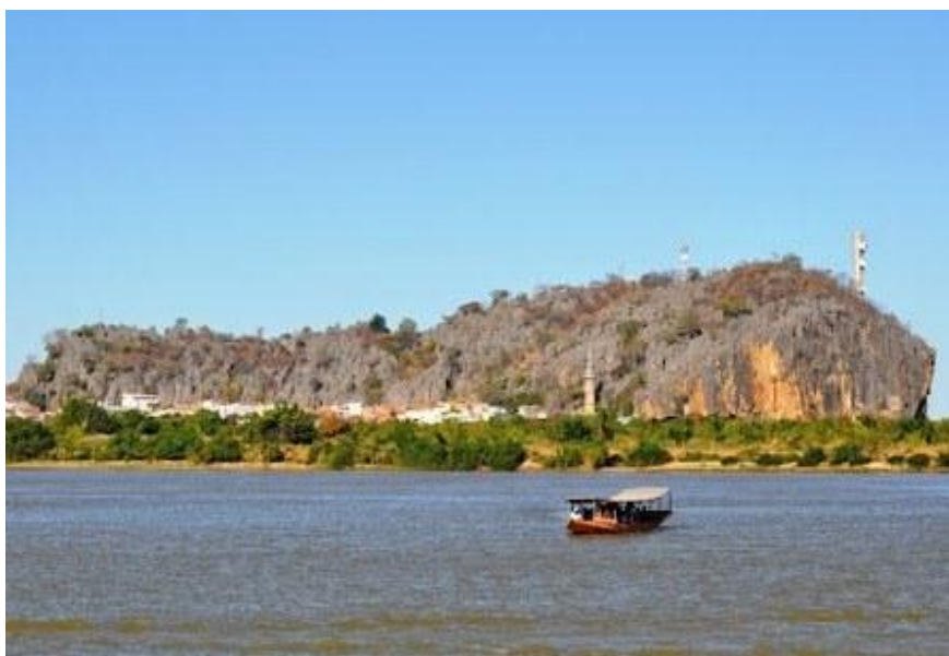
Figura 1 - A grande formação de pedras granito e calcária (“o morro da Lapa”), visto a partir das margens do Rio São Francisco.
