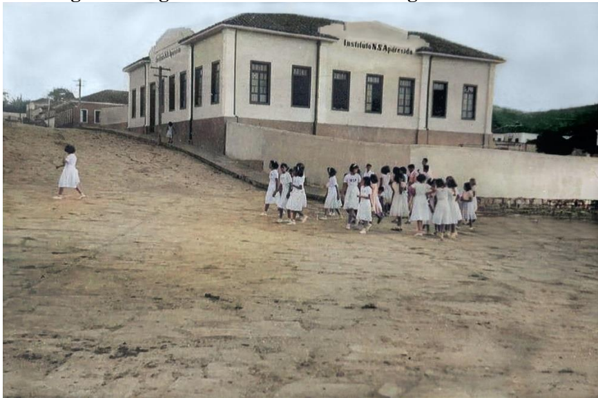
Figura 7: Segunda sede do INSA. Foto registrada em 1952
