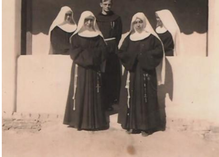
Figura 5: Chegada das Freiras Clarissas Franciscanas em Salinas/MG (1951)
