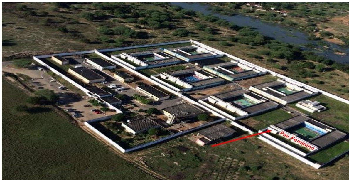
Figura 7 – Vista aérea do Conjunto Penal de Jequié
