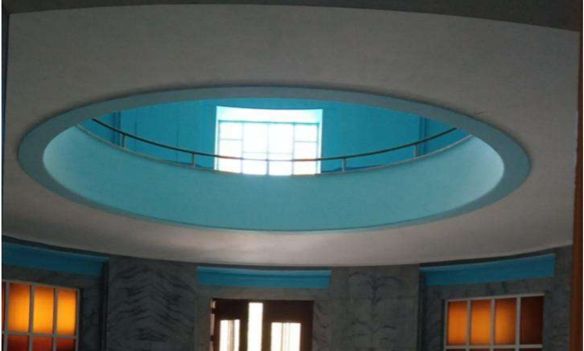
Figura 29: Vista interior del lobby del hospital, cuya estructura recuerda la forma de un útero
