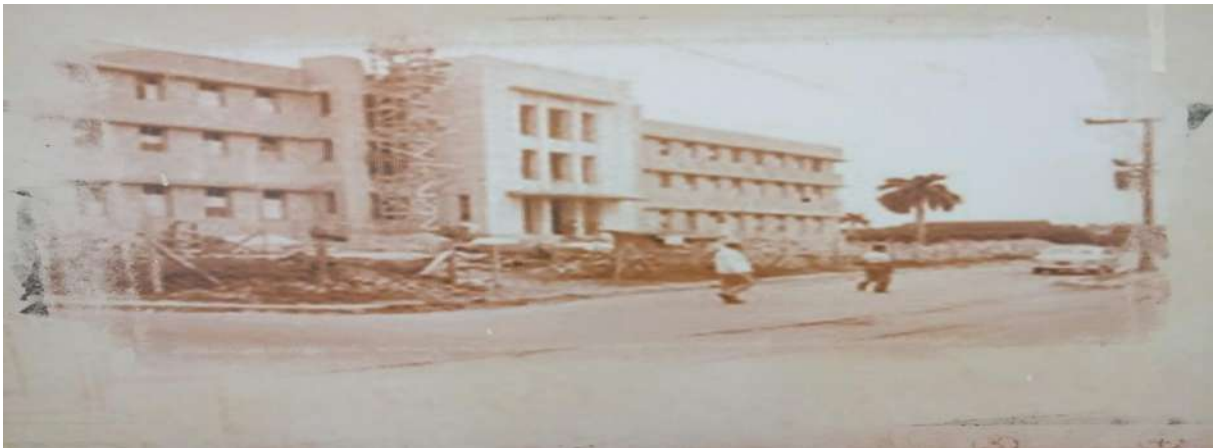
Figura 23: Hospital “Dr. Eusebio Hernández Pérez” en proceso constructivo
