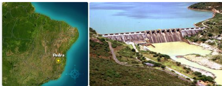
Figura 4. Barragem de Pedra – Jequié. Fonte: Chesf 31
