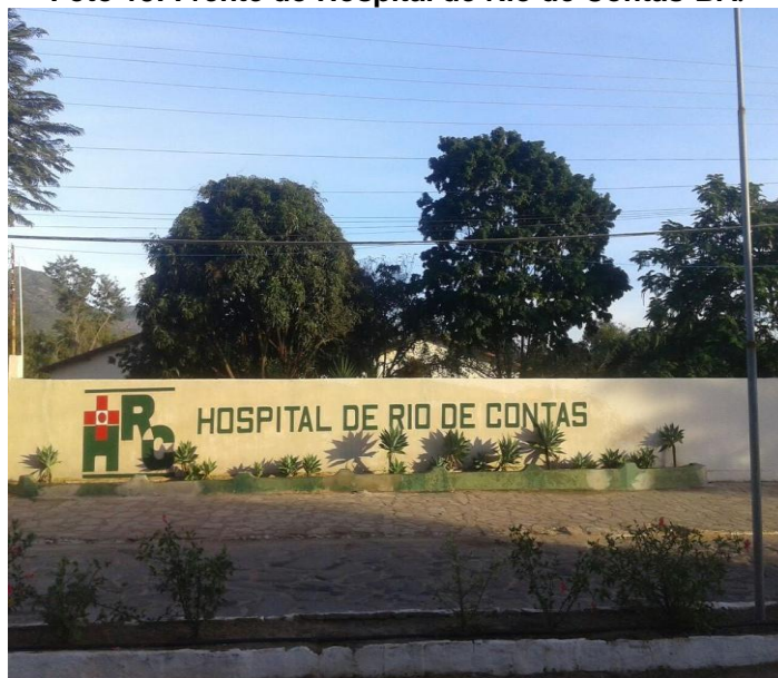
Foto 18: Frente do Hospital de Rio de Contas-BA.
