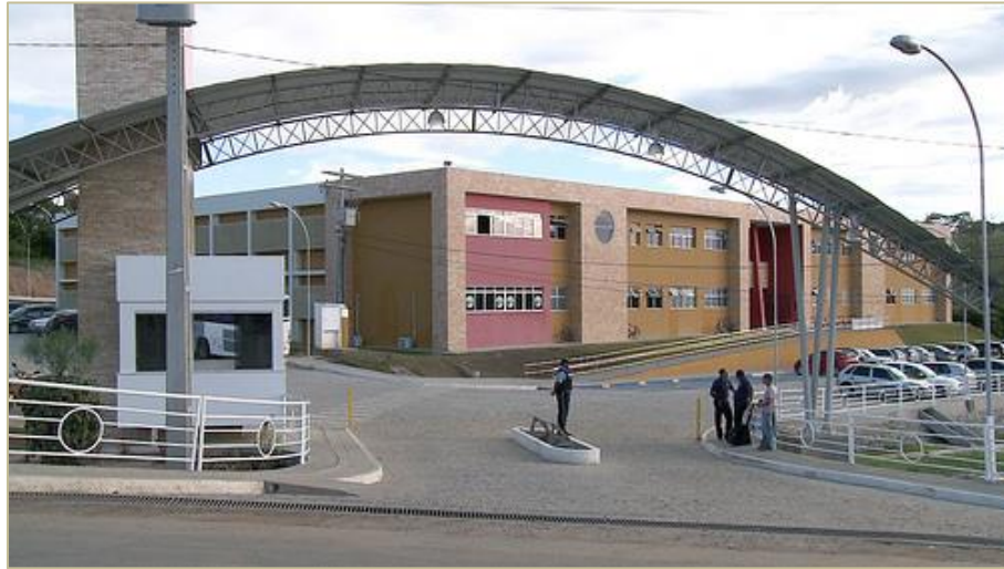
Figura 05 – Fachada do CFP/UFRB
